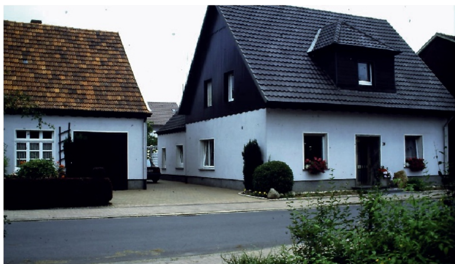
Das frühere Haus der Familie Heselhaus (Baujahr 1928) in der Oyenstrasse wird momentan zu einem Sechsfamilienhaus umgebaut.
