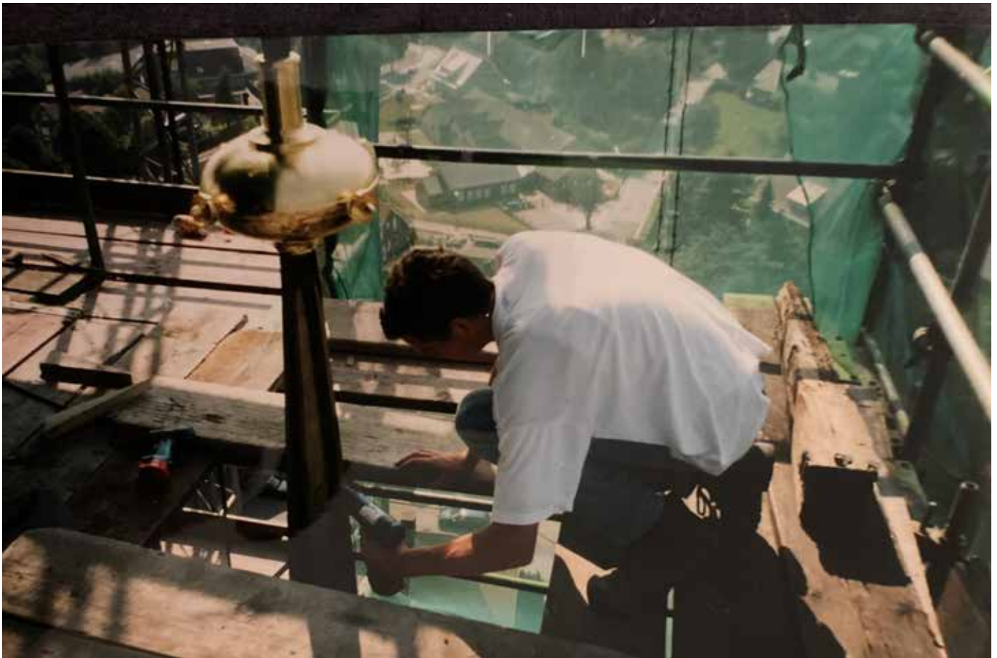
Konstantin Heselhaus auf dem eingerüsteten Turm
