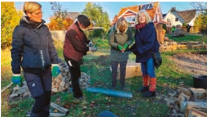
Zuschneiden der Drahtmatten für den Wühlschutz. Dieser wird um die Baumwurzeln gelegt.
