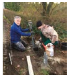
Einbetonieren der Pfosten-träger für die Info-Tafel am Zugang zur Streuobstwiese.
