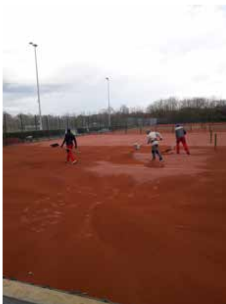
Hier ist Handarbeit gefragt! Bei der Platzaufbereitung wird unter anderem der alte Aschebelag abgetragen und neu aufgebracht.
