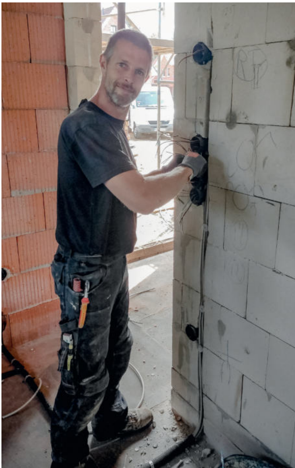
Elektroinstallateur Lars Henzel auf einer Baustelle.
